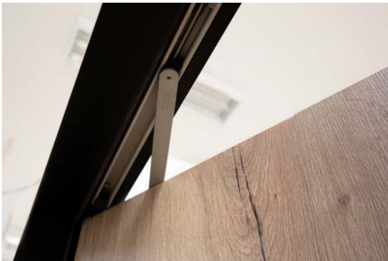
Skrytý samozavírač GEZE Boxer 2-4 včetně integrovaného koordinátoru zavírání pro dvoukřídlé dveře je funkčním a zároveň designovým prvkem.
