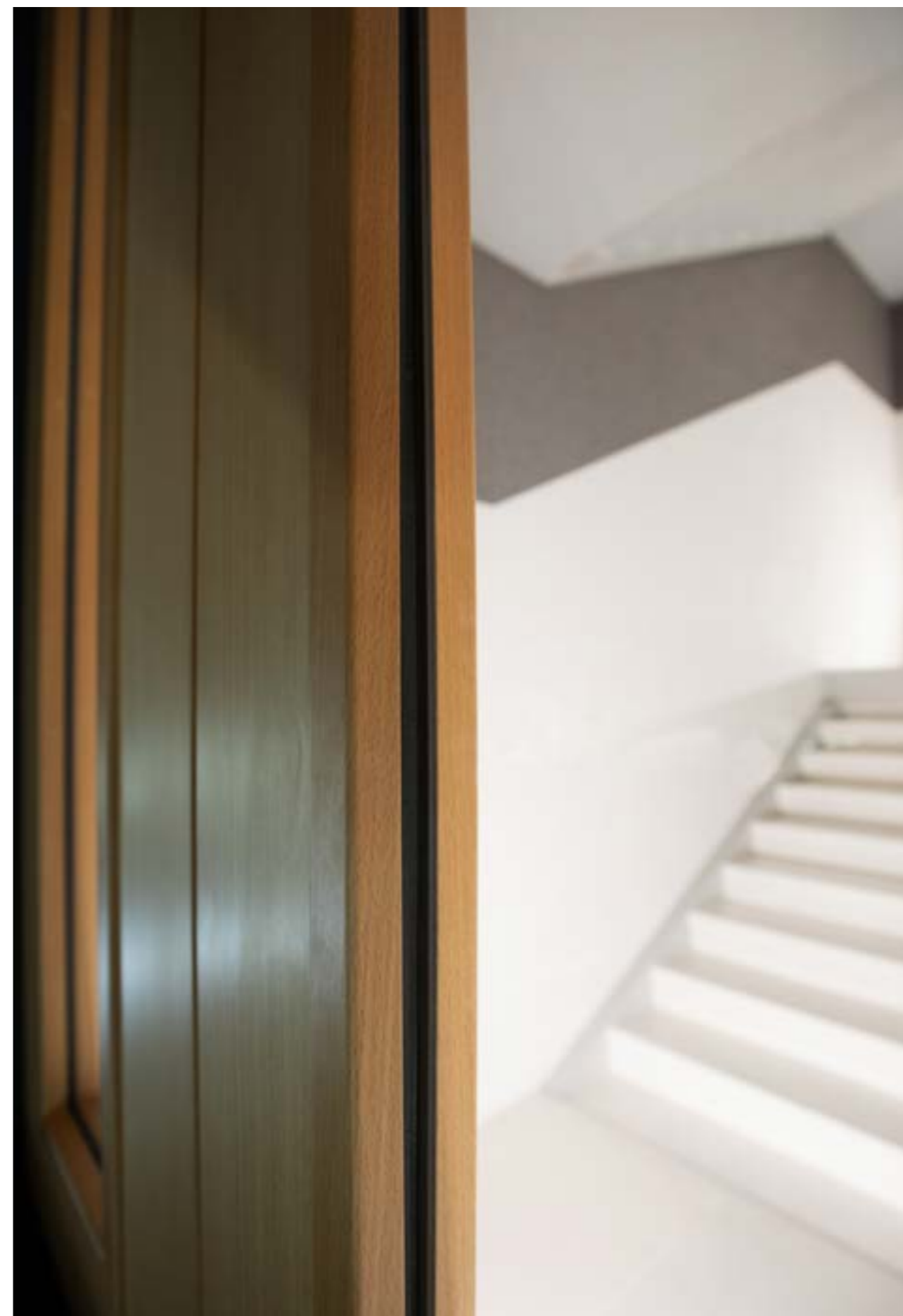
Bezvrutový způsob zasklívání požárního skla tloušťky 19 mm pro odolnost EI/EW45 vypadá skvěle.
