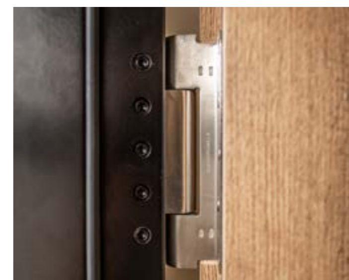
Kovová polodrážková zárubeň řady SAP s přípravou kapsy VX 7612 pro objektové kování Simonswerk.
