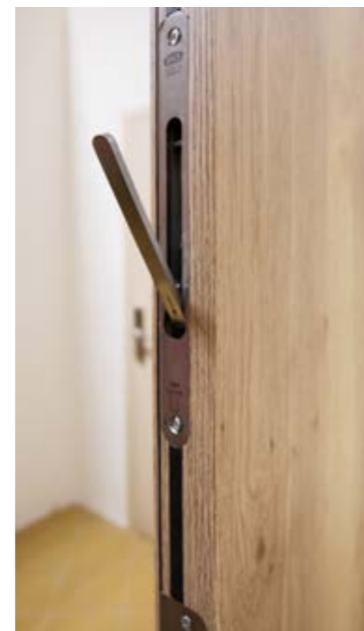
Automatická rozvora BKS B 1899, která automaticky ukotví pasivní křídlo po jeho dovržení.
