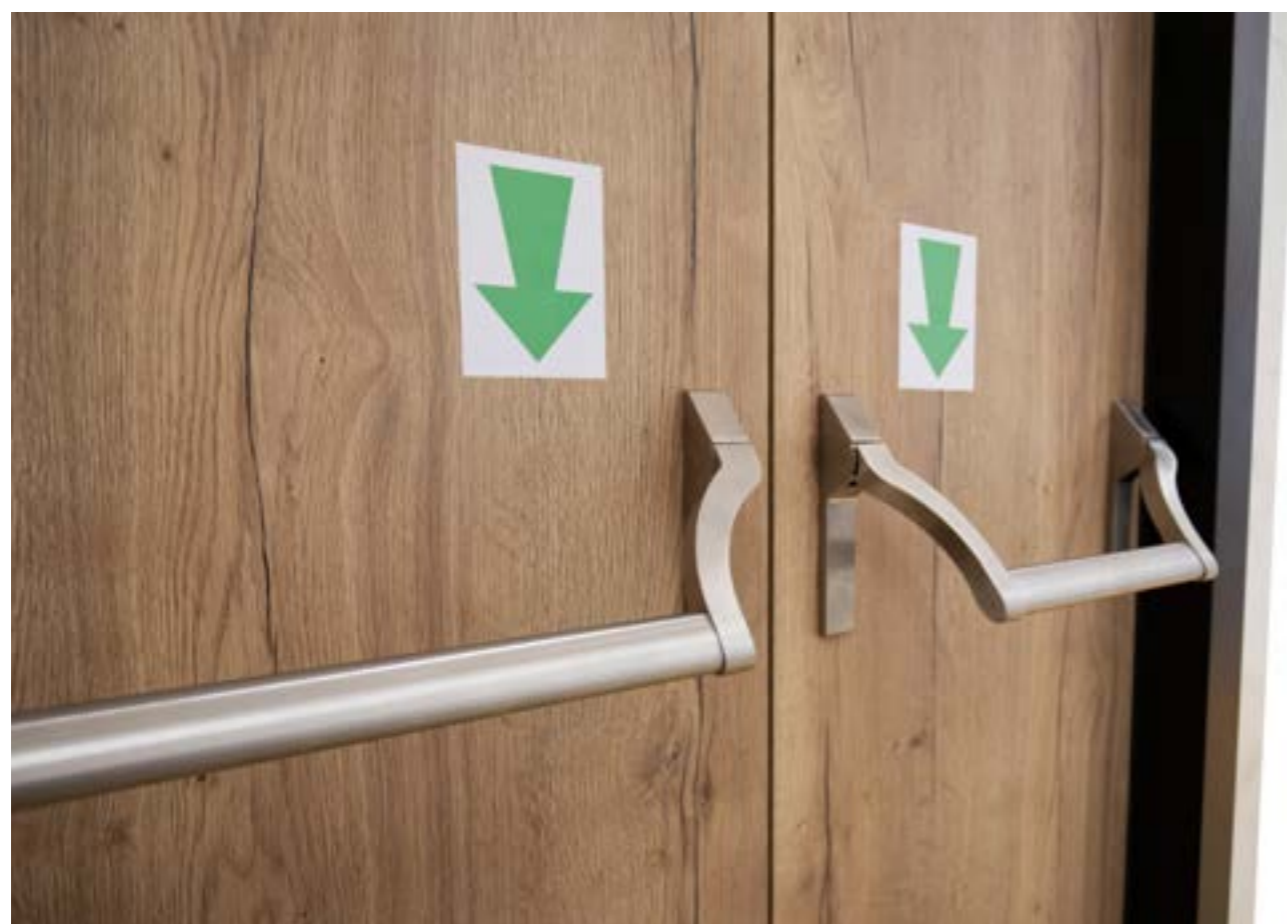
Panikové kování je kompletně zadlabané v konstrukci křídla. Na straně B jsou na ploše poté pouze hrazdy umožňující únik přes obě křídla dveřního kompletu. Na straně A je poté klika / koule dle zvolené konfigurace.
